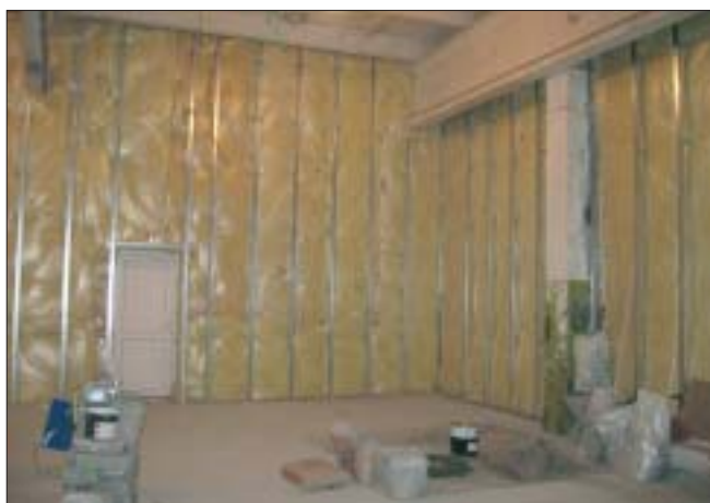
Строительные работы идут по продуманному плану, поэтому и работать в этом помещении будет легко и приятно
